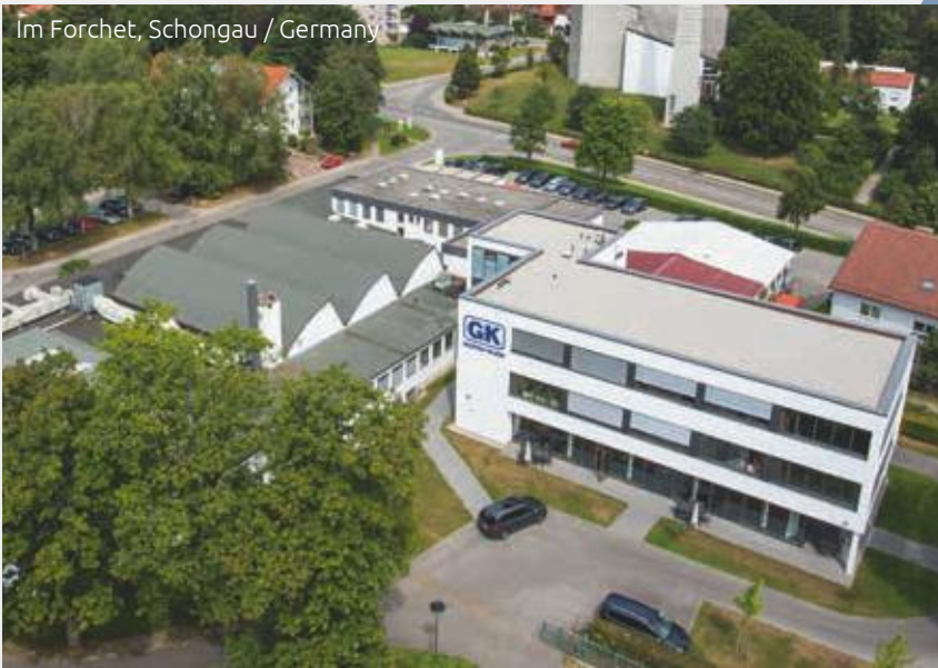
Greifenstraße, Schongau / Germany
